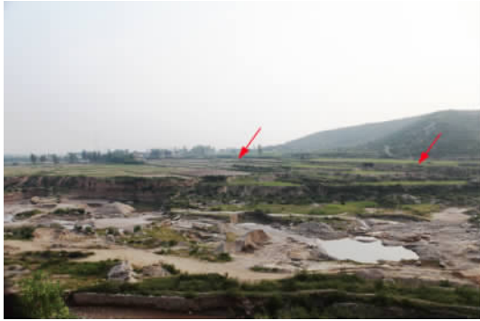
图 7 仙洞沟近出山口处断错地貌照片(镜向 SW)
