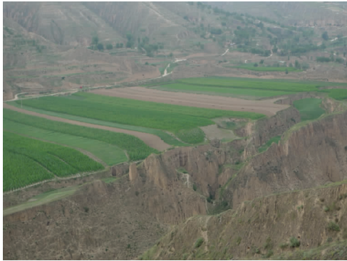
图 7 马刚堡南边城墙内的线性垮塌 (长 100 多米)
