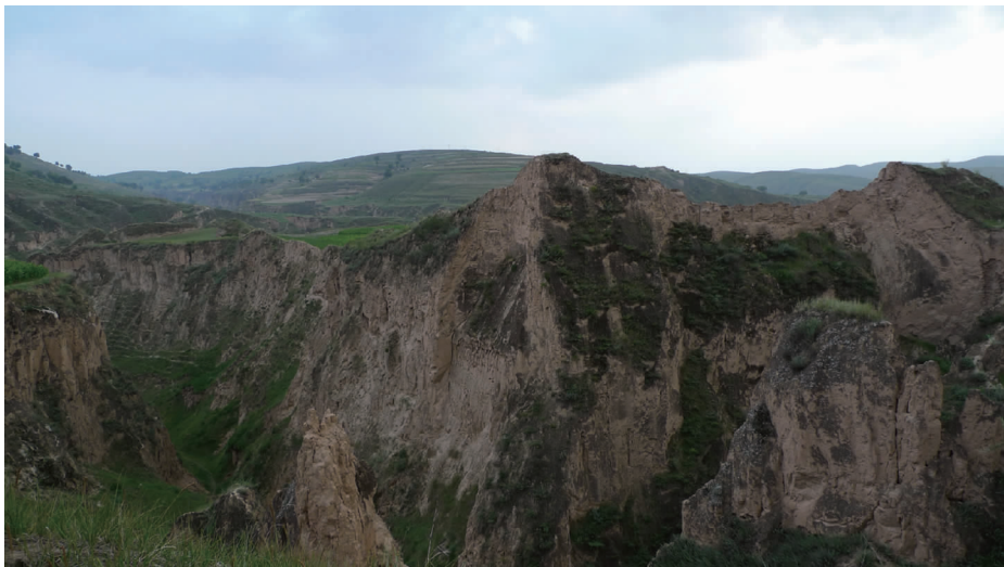
图6 马刚堡东北角及东城墙外侧垮塌
