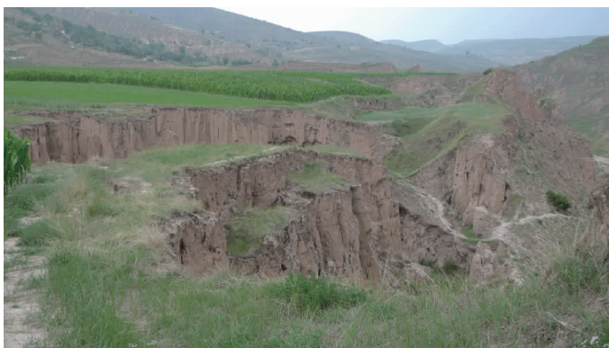
图 4 马刚堡南城墙的破坏情况
