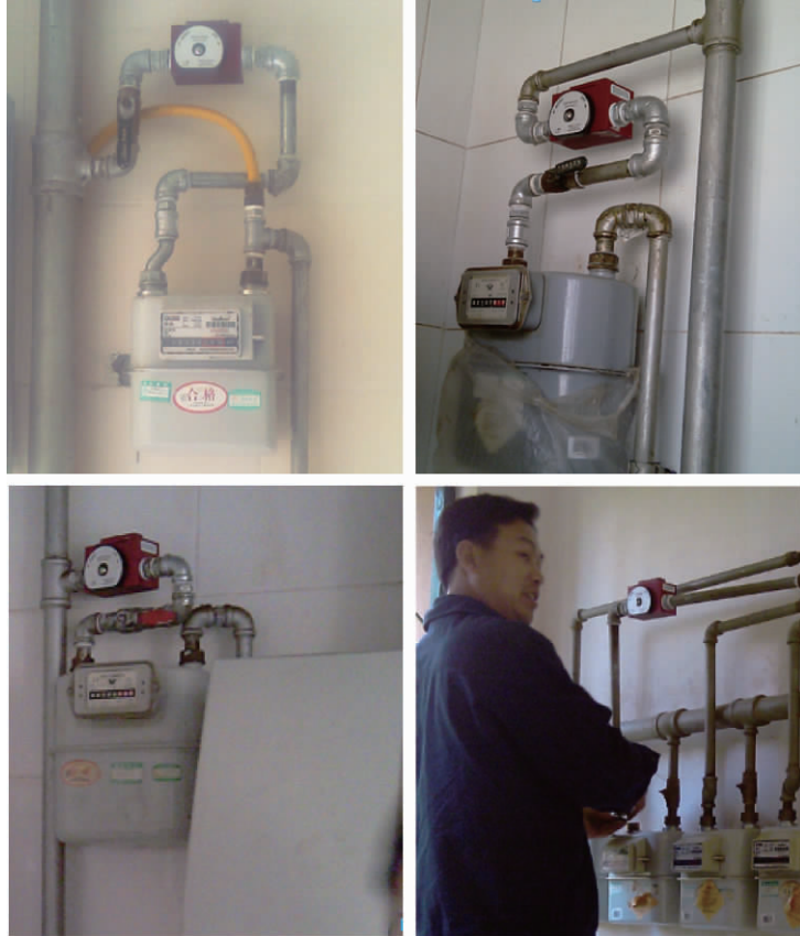
图 3 安装于 4 户居民燃气管线上的 Northridge 2000M75 地震燃气阀门
